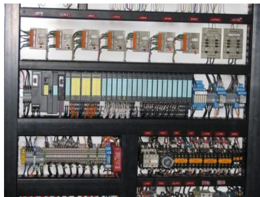
Rys. 4 Stacja ET 200S – Master
