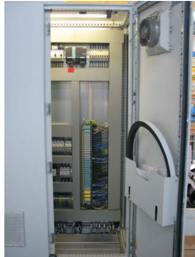
Rys. 11 Przykładowa szafka sterowania rozproszonego mastera S7-400
