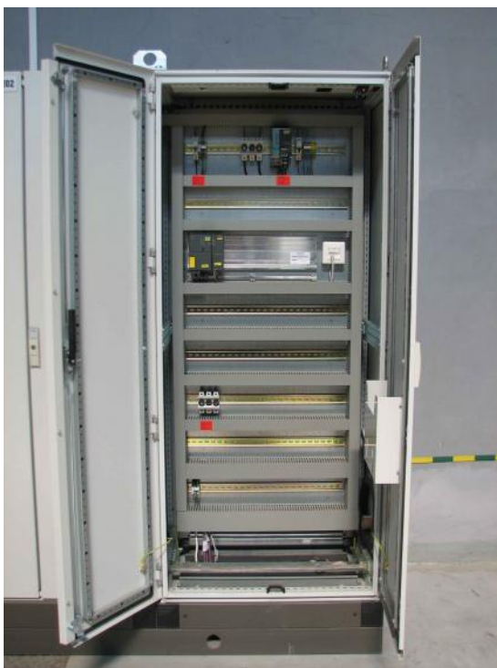
Rys. 2 CPU S7-317F sterujący sekcją wejściową linii
