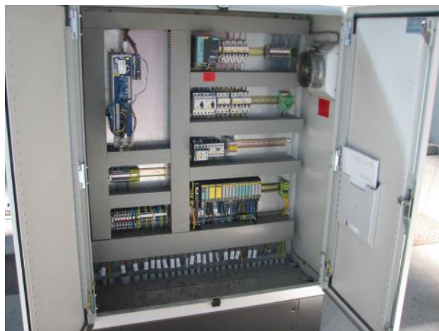
Rys. 3 Przykładowa szafka ze stacją ET200S sekcji wejściowej
