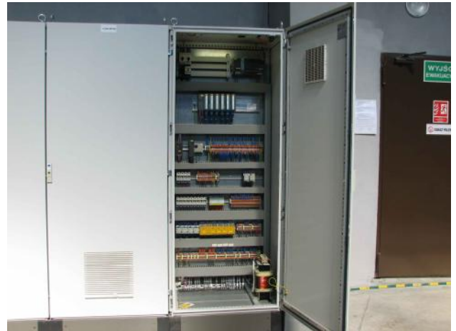
Rys. 5 CPU steruj ce nalewakami piany
