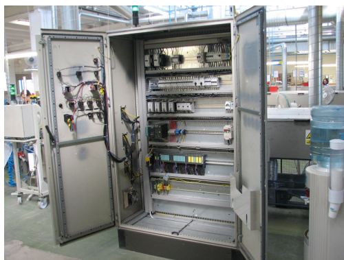
Zdj. 3 Nowa zabudowa szafy sterowniczej
