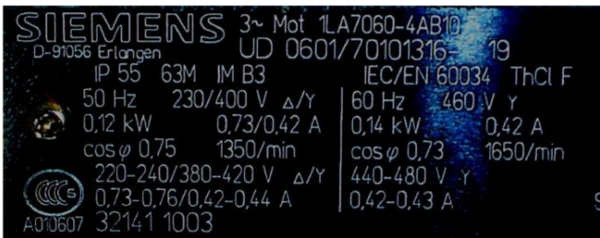
Rysunek 3-1 Tabliczka znamionowa silnika użytego w przykładzie
